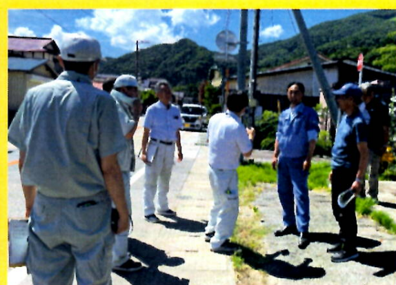
●滑津地区『国道113号』側溝整備
