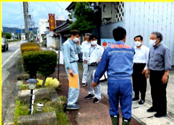
●城北地区『国道113号』縁石整備
