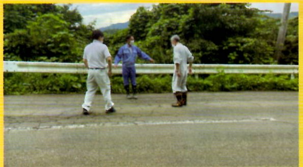
●福岡蔵本地区『県道南蔵王白石線』 舗装補修、道路整備
