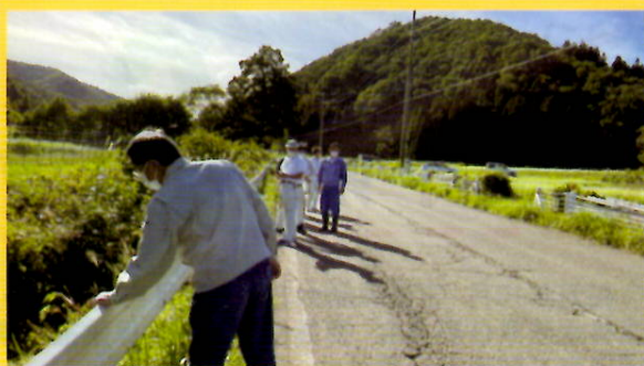
●湯原地区『国道113号』舗装補修 道路整備
