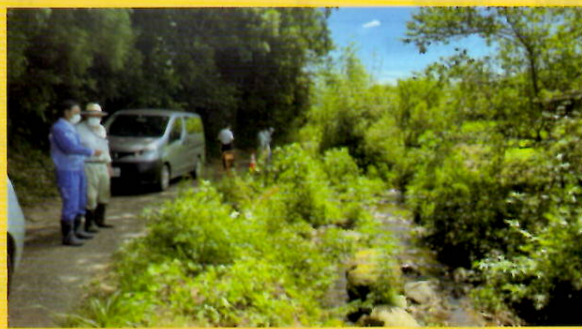
●福岡深谷地区『大太郎川』災害復旧 河川及び道路整備
