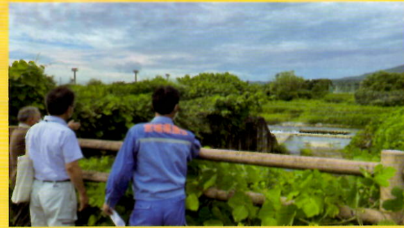
●永野地区『松川』河川整備用に堤防改良
