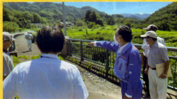
●小原地区『国道113号』橋梁及び道路整備
