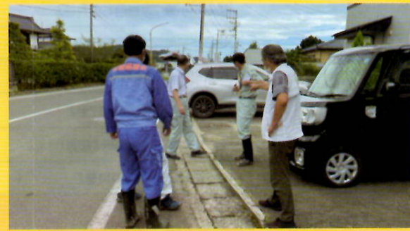
●宮地区『県道岩沼蔵王線』側溝整備
